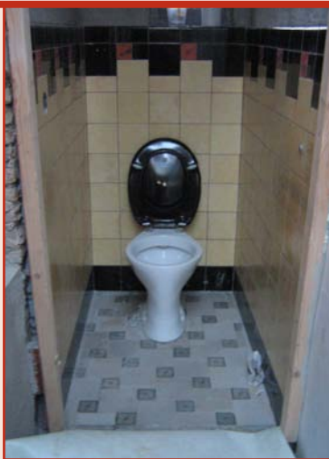
Het toilet aan het Klein Nieuwland in wording
