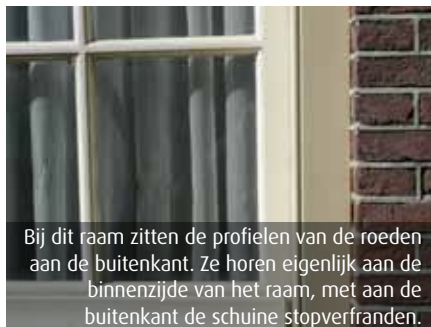
Het raam na plaatsing van isolatieglas. De originele indeling is terug met gebruik van plakroeden en schuine stopverfranden.
