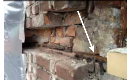
Eén van de verroeste blindankers in de muur
