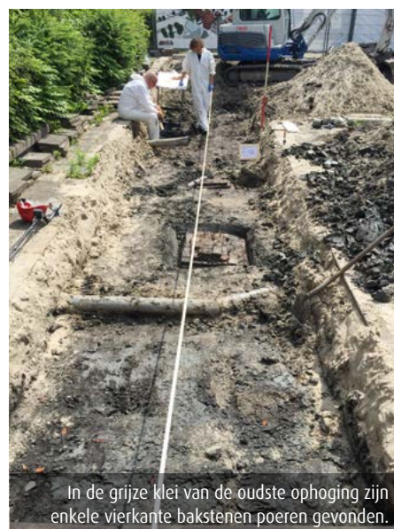
Aanleg van een sleuf in het hoofdplein.
