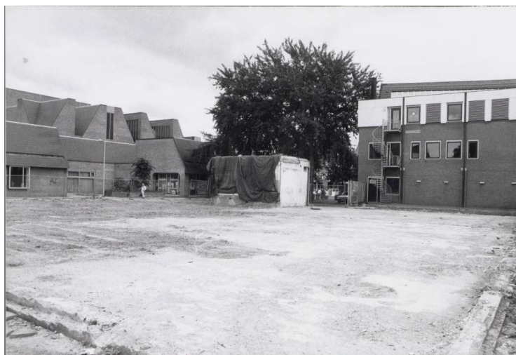
Afb. 2 De betonvloer van het Zwembad na de bovengrondse sloop in 1990
