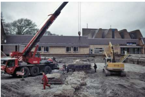
Afb. 7a-e (links naar rechts) De berging van een stuk stadsmuur: a. Muurblok diep ontgraven, waterpas gelegde onderbalk met opgelaste sleep- ogen. b. Waterpas inbrengen van stalen H- balken. c. Inbrengen van stalen platen over de balklaag heen. d. Oplassen van de zijwanden. e. Proef met optillen (geslaagd)
