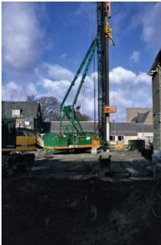
Afb. 5a Zwaar materieel voor het boren van de betonwanden (1999)
