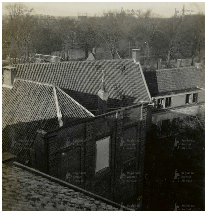
Afb.14 De regentenkamers en de westvleugel van het Stadsziekenhuis vlak voor de sloop in 1930, anonieme foto (Regionaal Archief Alkmaar)
