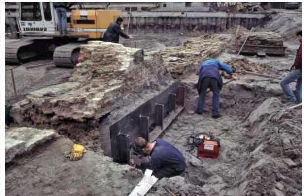
Afb. 7a-e (links naar rechts) De berging van een stuk stadsmuur: a. Muurblok diep ontgraven, waterpas gelegde onderbalk met opgelaste sleep- ogen. b. Waterpas inbrengen van stalen H- balken. c. Inbrengen van stalen platen over de balklaag heen. d. Oplassen van de zijwanden. e. Proef met optillen (geslaagd)
