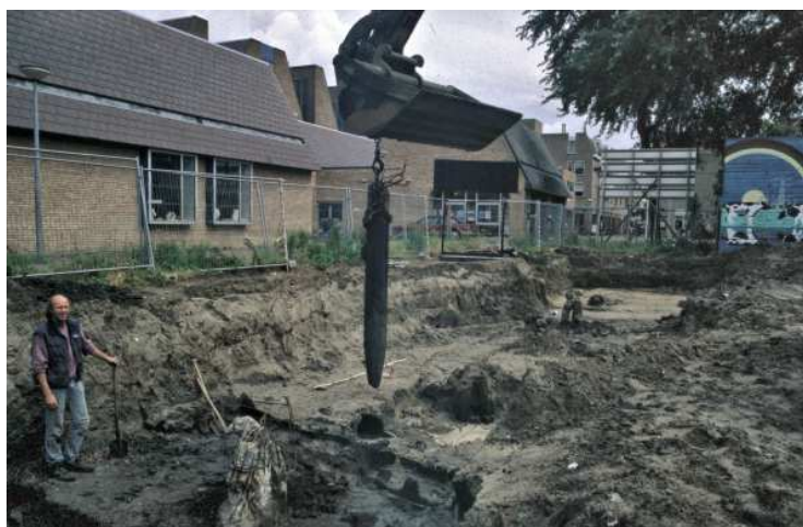
Afb. 3 Het uittrekken van de heipalen uit 1935
