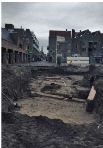
Afb.45a-c Funderingen van de westvleugel met aansluiting op de middenvleugel (9F), met buiten het gebouw gesitueerde kelderhoek 9/11C: a-b. vanuit het westen gezien en c. vanuit het oosten
