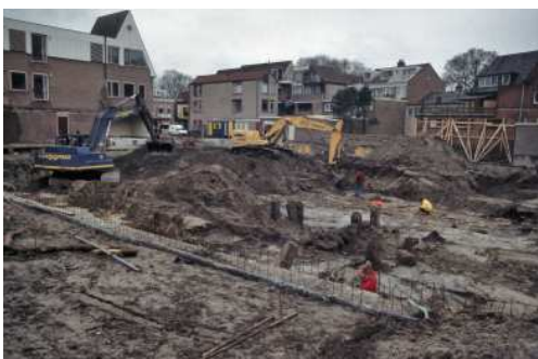
Afb. 5b Ontgraven van de bouwput met bronbemaling
