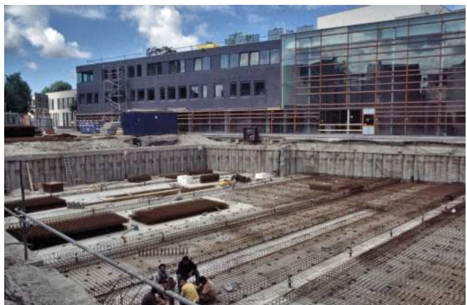
Afb. 10a-c (van boven naar beneden) Bouw van de kelders: a. Stedelijk Museum medio 1999. b-c. fietsenstalling medio 2000
