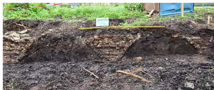
Spaarboogfundering voor- en zijgevel.
