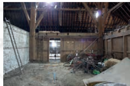
Foto boven: Stuk betegelde haardwand, tussen het slooppuin van het voorhuis
