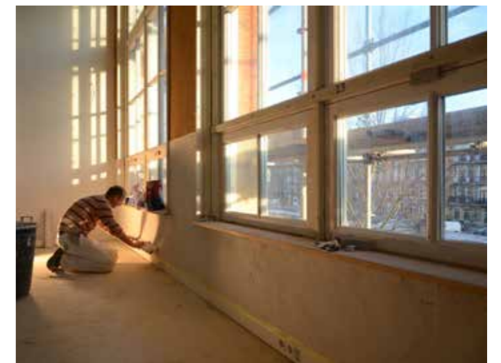
Foto boven: Na-isolatie aan de binnenkant van een dak Foto onder: Na-isolatie van een raam (Foto's: De Groene Grachten)
