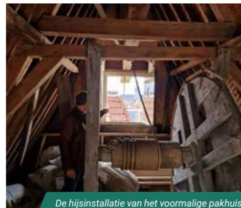
De hijsinstallatie van het voormalige pakhuis aan het Fnidsen is nog aanwezig
