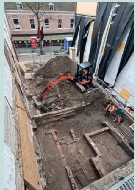
Overzicht van de opgraving vanuit het noorden, met op de voorgrond de middeleeuwse huisresten
