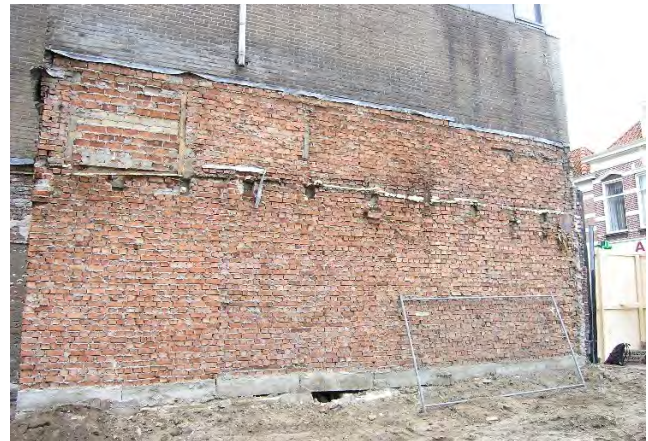
Afb.2-14a-b De zijmuur van Ritsevoort 58/60 werd in de 20 ste eeuw ook gebruikt bij de nieuwbouw van het buurpand Ritsevoort 56.
