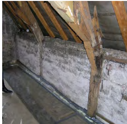
Afb.2-12a-b en 2-13 Kap met gebogen dekbalkspanten, waaraan de muurplaat met blokkelen is bevestigd; 2-12a-b de zuidelijke borstwering met originele muur, 2-13 bij de noordelijke borstwering is de spant vóór de nieuwe zijmuur gezet.
