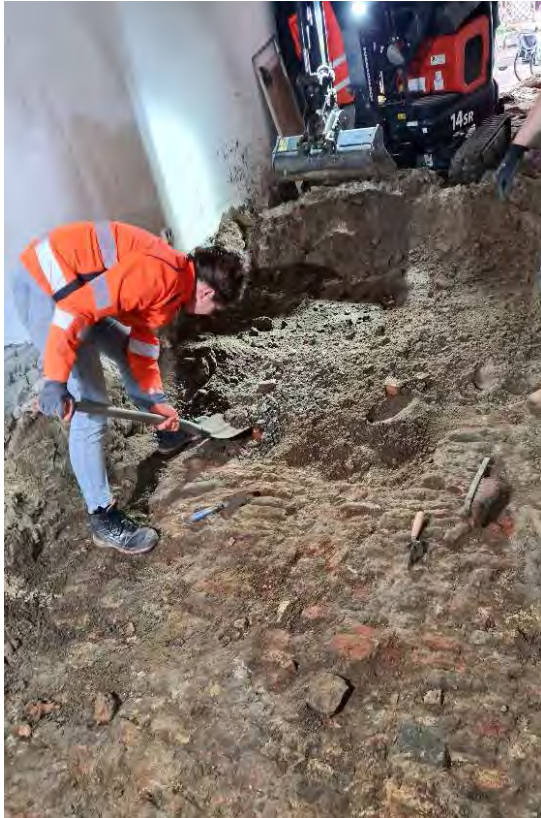
Afb.6-12 Baksteenstraatje 3B in het achterhuis: d. het vrij leggen van de bestrating was lastig door het vele losse puin; e. onder de bestrating was een soort ondervloer gemaakt van mortel en puin
