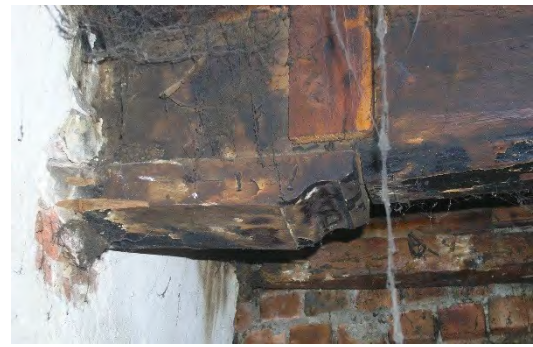
Afb.2-9 t/m 2-11 De vierde balk van het achterhuis toont het gat van een korbeel en nummers 3 en 1 hebben een sleutelstuk met ojiefprofiel.
