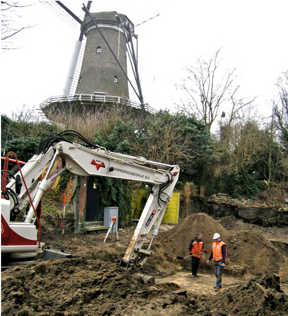
Afb.2-2 Aanleg van werkputten met de graafmachine en schep.
