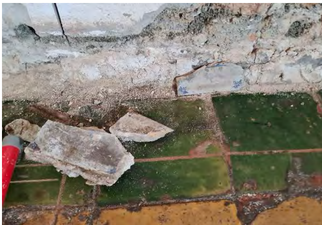
Afb. 6-17 Plint van wandtegels aan de Zuidmuur (5D), met plavuizenvloer 5F ertegenaan; Vondsten (23RTV15) schaal 1:4
