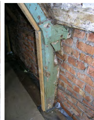
Afb.2-12a-b en 2-13 Kap met gebogen dekbalkspanten, waaraan de muurplaat met blokkelen is bevestigd; 2-12a-b de zuidelijke borstwering met originele muur, 2-13 bij de noordelijke borstwering is de spant vóór de nieuwe zijmuur gezet.
