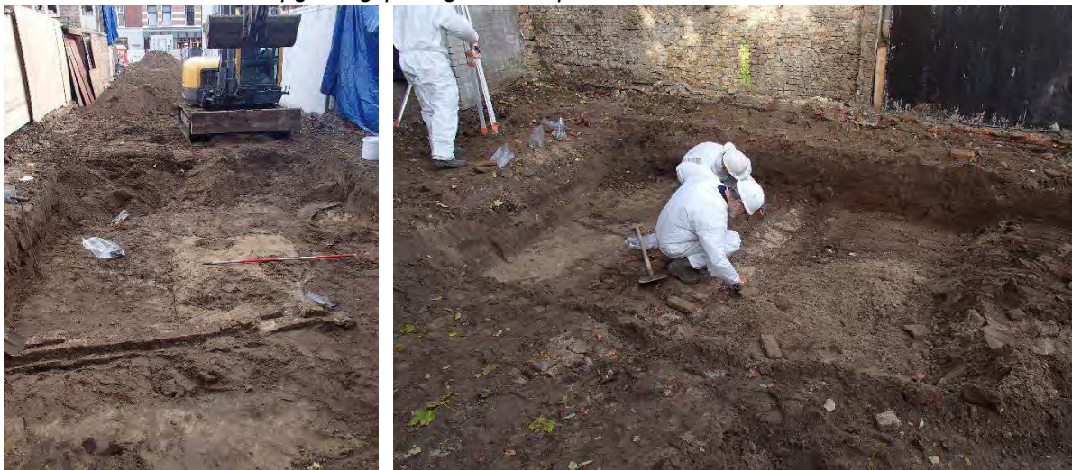
Afb.4-41 Fundering 5E gezien uit het westen en uit het zuiden, met ten zuiden ervan de grote kuil 7G die zal zijn gegraven voor het opruimen van de zuidmuur van het pand
