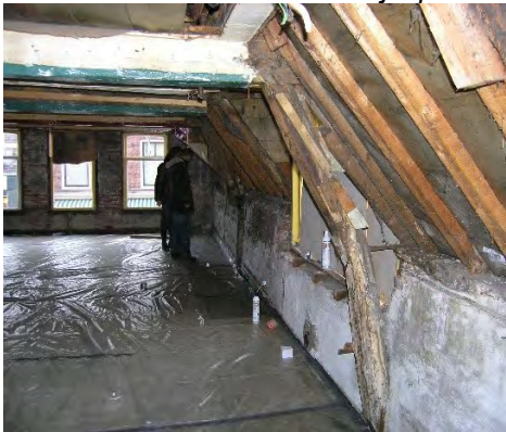
Afb.2-12a-b en 2-13 Kap met gebogen dekbalkspanten, waaraan de muurplaat met blokkelen is bevestigd; 2-12a-b de zuidelijke borstwering met originele muur, 2-13 bij de noordelijke borstwering is de spant vóór de nieuwe zijmuur gezet.
