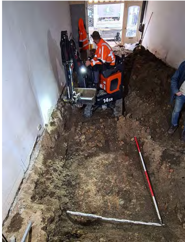
Afb.6-12 Baksteenstraatje 3B in het achterhuis: d. het vrij leggen van de bestrating was lastig door het vele losse puin; e. onder de bestrating was een soort ondervloer gemaakt van mortel en puin
