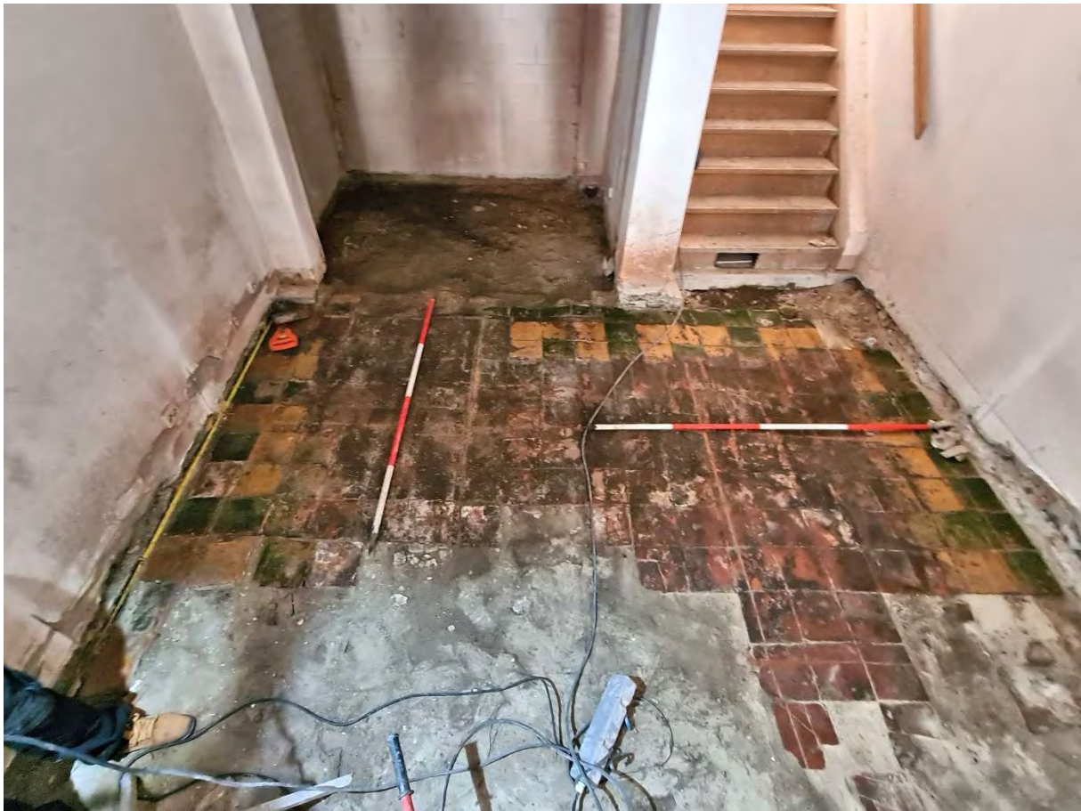
Afb.6-18 De vloer 5F in de achterkamer bestaat uit sterk versleten geel en groen geglaazuurde plavuizen, in een lichtgrijs mortellaagje op fijn geel zand.
