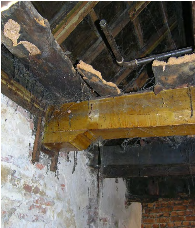
Afb.2-9 t/m 2-11 De vierde balk van het achterhuis toont het gat van een korbeel en nummers 3 en 1 hebben een sleutelstuk met ojiefprofiel.
