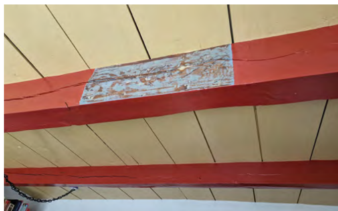
De oorspronkelijke versieringen op de balken zijn hier en daar nog zichtbaar
