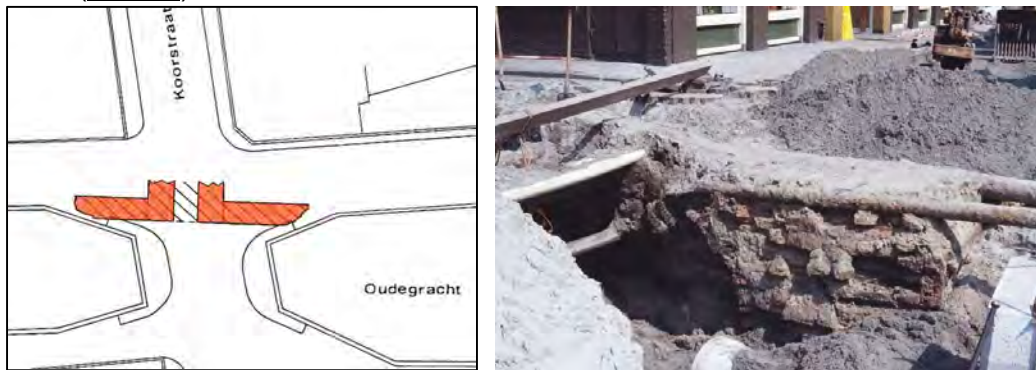
Afb. 1.5 Resten van de Kennemer- of Gevangenenpoort, gevonden bij rioolwerkzaamheden: a. opmeting van W.J. Reder uit 1960, b. foto uit 1981 vanuit het zuiden, met op een paar decimeter onder het wegdek een grondboog van de stadsmuur, in verband gemetseld met de westelijke zijkant van de poortdoorgang (Regionaal Archief Alkmaar)
