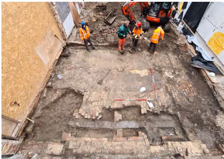
Afb.1.30a Eerste vlak in werkput 1: bakstenen ondervloer 7G uit 1908, afgesmeerd met cement, met poertjes voor de houten vloerbalken. Op de voorgrond de betonnen gootfundering 7Q uit de jaren 1990
