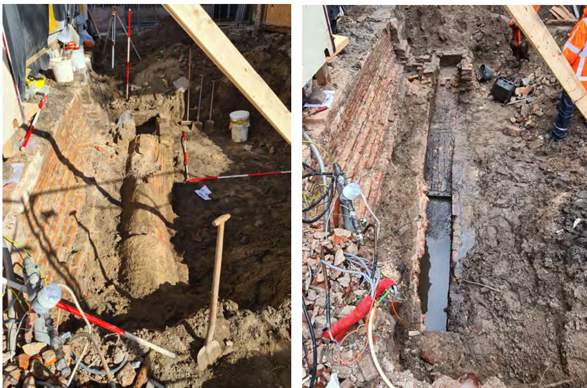
Afb.1.28a-b Onderzoek van riool 5C, gezien vanaf het zuiden (Lindegracht), met aan het noordeinde een dubbel breed privaat: a. het gewelf is tweemaal deels vernieuwd; b na het verwijderen van het gewelf en leeg halen van het riool bleek een deel van de bodem van hout te zijn
