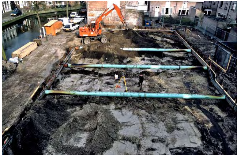
Afb.2.4 Onderzoek in de bouwput na het plaatsen van de damwanden en stempels (horizontale buizen)
