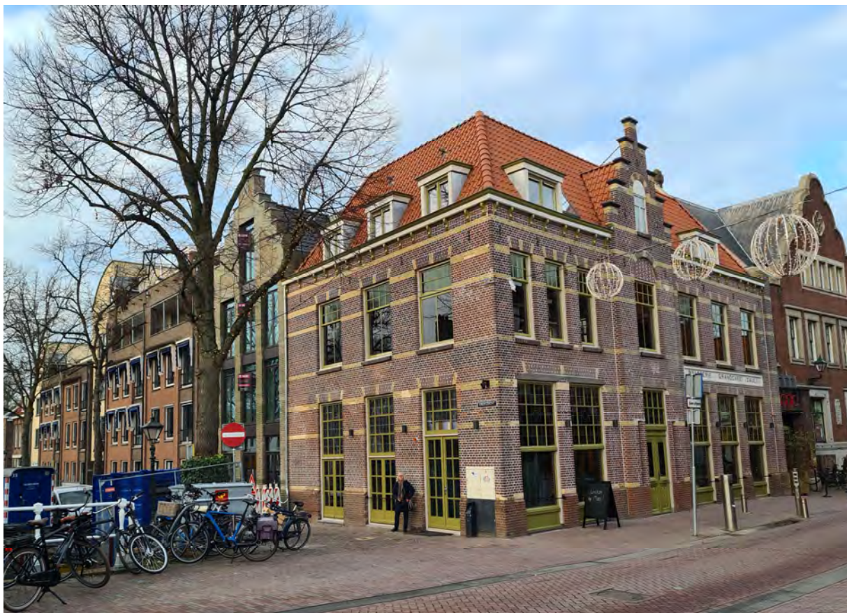
Afb. 1.1 Café-restaurant Mooij na de restauratie met aan de Lindegracht ernaast de nieuwbouw met de mosgroene trapgevel (december 2022)
