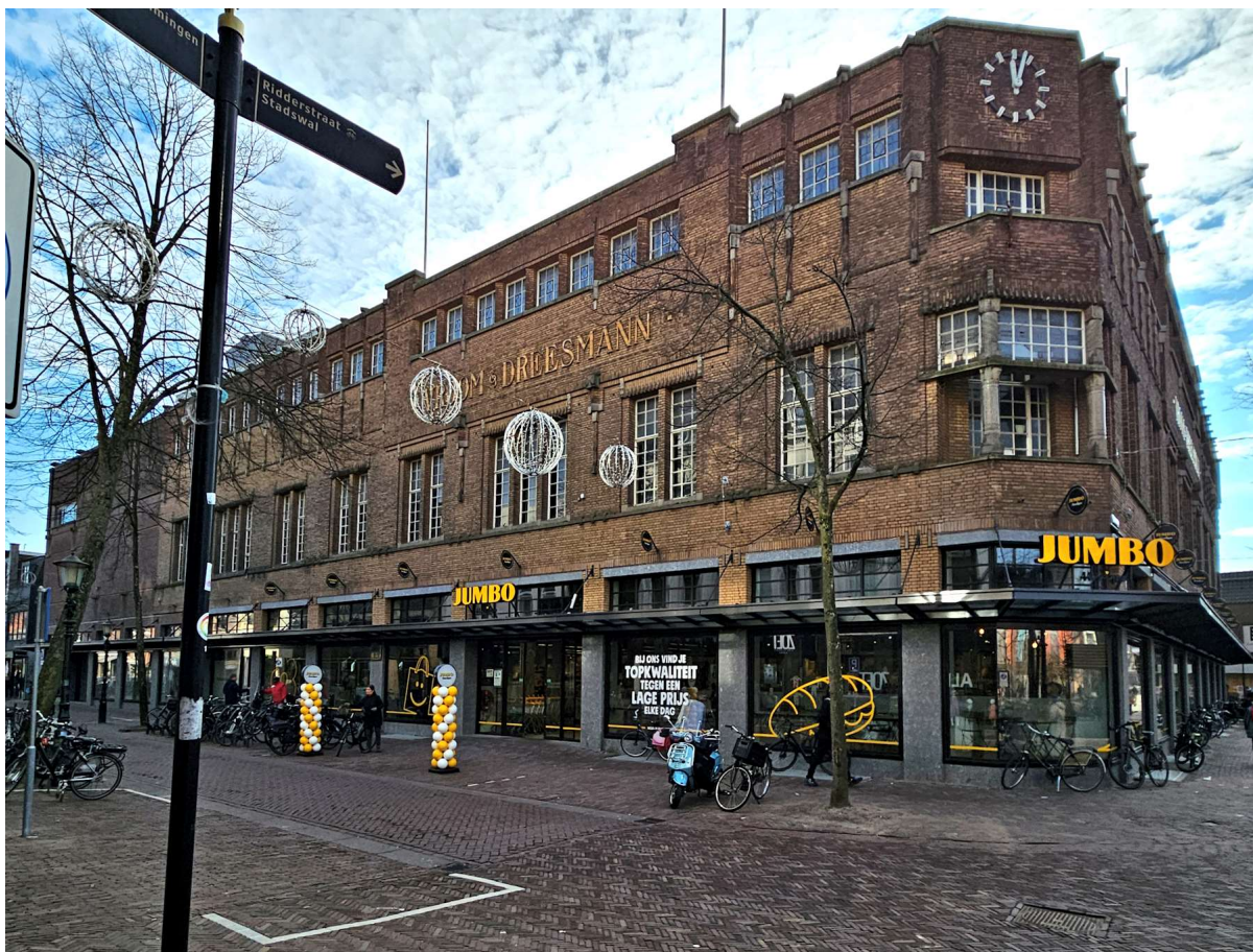
Afb. 1.10a Opname van het voormalige warenhuis met op de begane grond de supermarkt van Jumbo Monique. In de rest van het pand worden appartementen gerealiseerd (foto auteur, februari 2025)
