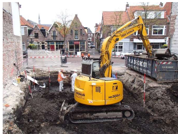
Afb.2.8-2.10 Na sloop van een betonvloer volgen graafwerk met kraan en schep, opmeten en tekenwerk, berging en documentatie van vondsten
