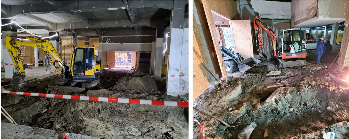
Afb. 1.2 Manoeuvreren in een krappe werkruimte met de elektrische graafmachine en de shovel
