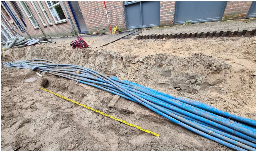
Afb. 18 Fundering 1/2H naast Zevenhuizen 44, vanuit het noorden
