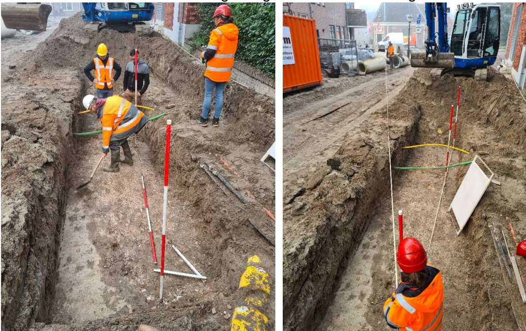
Afb.11 Spoor 2G is de grondverbetering onder een zware muur langs de 'oude Geestweg'. Met een lint is de rooilijn aangegeven richting de hoek van de Geest
