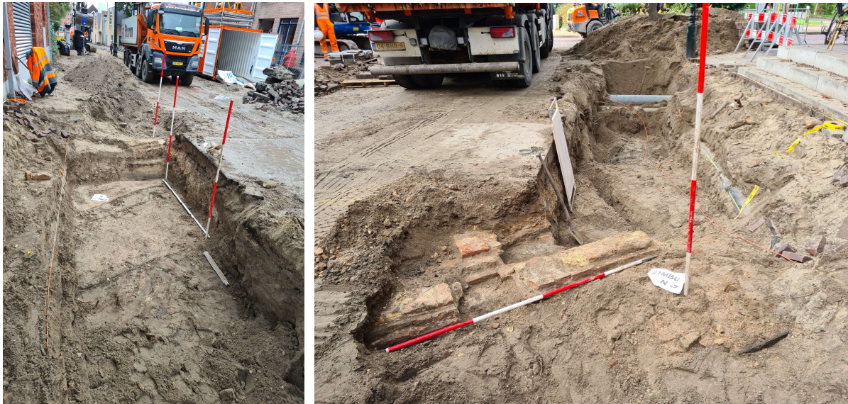
Afb.8 De werkruimte was in 2021 beperkt, omdat de vrachtwagens langs de werkput moesten rijden.
