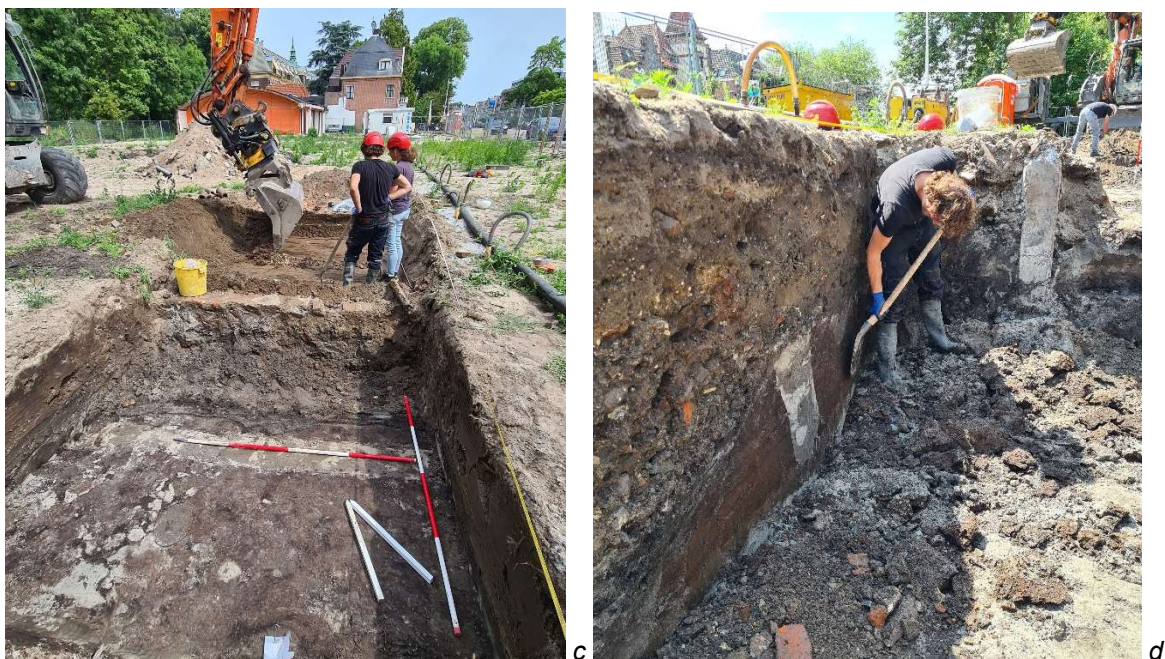
Afb. 18 De met zand gevulde standgreppel voor vlechtwerk hek 1C: c. in het vlak vanuit het zuiden gezien en d. in het profiel
