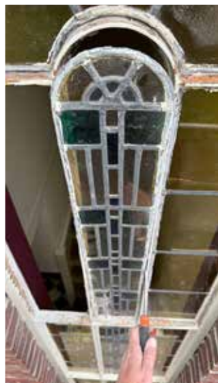
Foto boven: Restauratiewerk aan het raam, aan de buitenkant.
