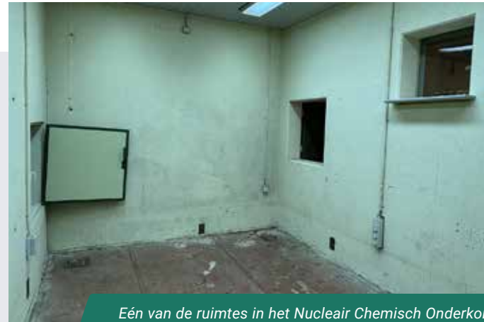
Eén van de ruimtes in het Nucleair Chemisch Onderkomen, met noodluiken naar andere ruimtes
