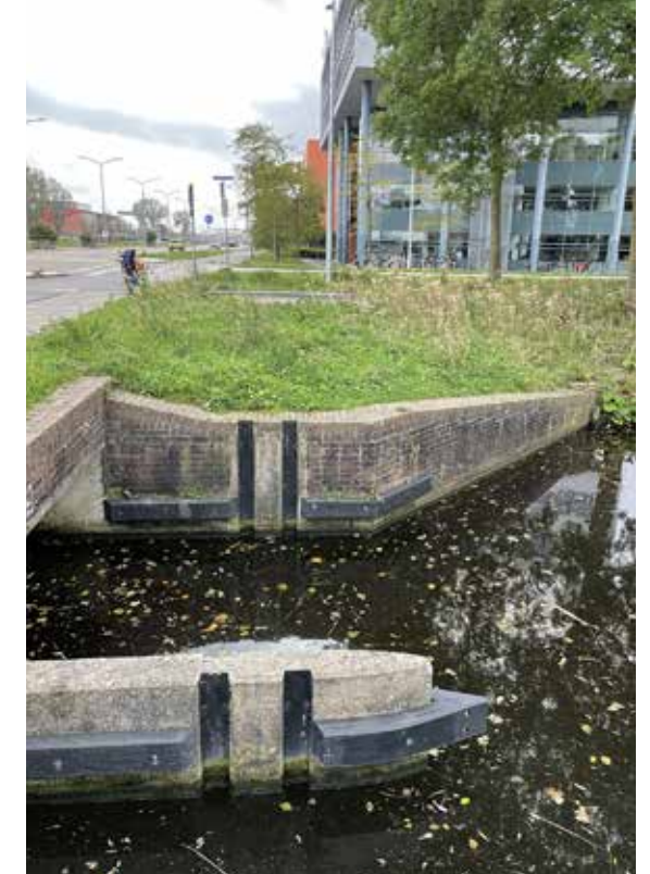
Ook veel bruggen langs de Helderseweg zijn aangepast in de periode van de Koude Oorlog. Met gleuven voor stalen balken om de grachten te kunnen afsluiten van het Noordhollandsch Kanaal.
