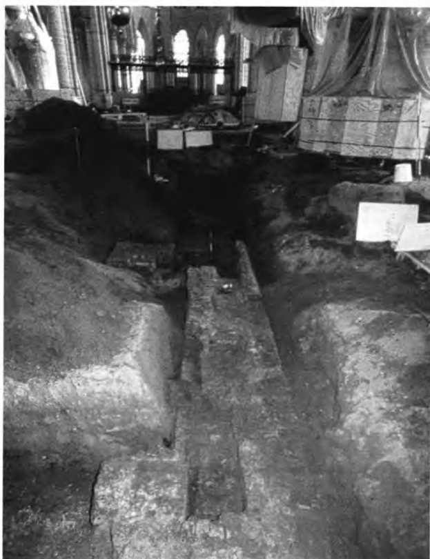
De zware funderingen midden in het schip. Geheel op de voorgrond een deel van de torenfundering 4B/5F. Foto gemeente Alkmaar, afdeling monumentenzorg en archeologie.
