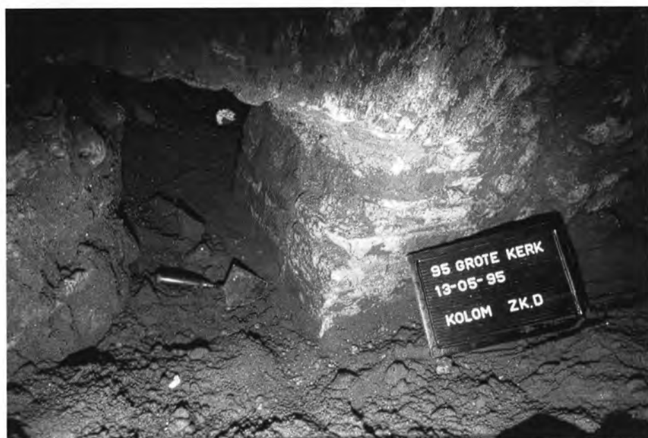
Onder de scheidingsmuur tussen zuiderkapellen C en D werden oudere funderingen aangetroffen. Bij de troffel bevindt zich een bouwnaad tussen de steunbeer 5D en muur 6C. Foto gemeente Alkmaar, afdeling monumentenzorg en archeologie.
