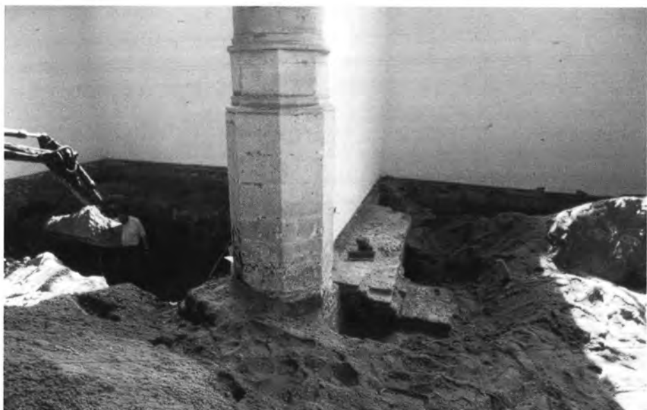
De scheidingmuur tussen zuiderkapellen A en B rust op de oude fundering van een steunbeer (6B). Foto gemeente Alkmaar, afdeling monumentenzorg en archeologie.
