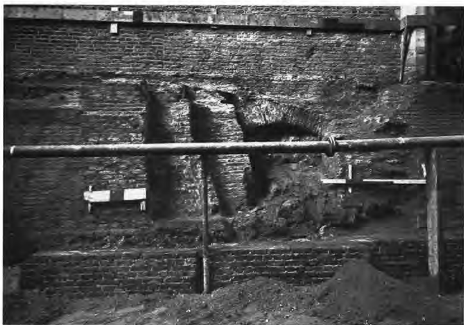
Foto van de westmuur van het zuidtransept, genomen in de bouwput van de verwarmingskelder in 1942. Onder de scheidingsmuur met zuiderkapel F zijn rechts de afgehakte oude funderingen (5E) te zien van de kerk van vóór 1470, met ernaast een spaarboog. Links daarvan zijn zware steunberen (8B) aanwezig ter hoogte van de zuidmuur van de zuiderkapellen. Foto Regionaal Archief Alkmaar.
