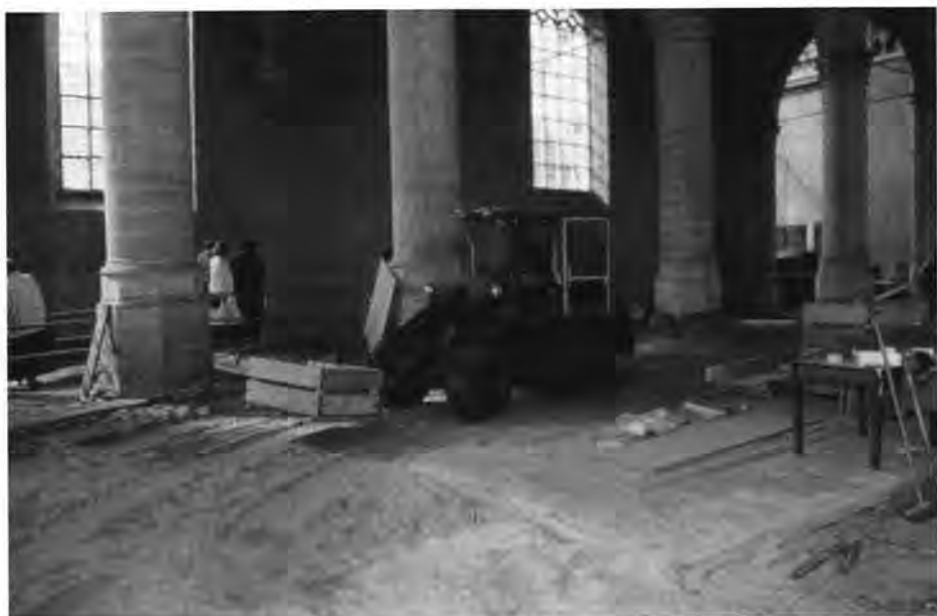
Voor de afvoer van de zerken (en brokstukken ervan) zette de aannemer een shovel in. Foto gemeente Alkmaar, afdeling monumentenzorg en archeologie.
