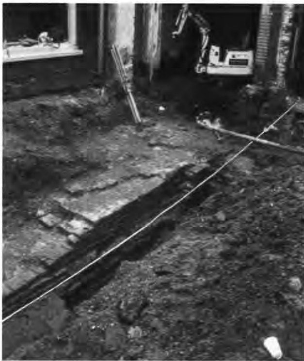
Bij een winkeluitbreiding aan de Langestraat 16-18 werd in 2000 een deel gevonden van een buitengewoon zwaar gefundeerd bakstenen huis van 9 meter breed en minstens 22 meter lang, dat in de dertiende eeuw aan de Houttil stond. Het achterste gedeelte had het karakter van een woontoren, terwijl het voorgedeelte aan de straat iets minder zwaar gefundeerd was. Foto gemeente Akmaar, afdeling monumentenzorg en archeologie.
